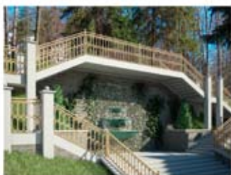
D. SCHODY DO INHALATORIUM Część dolna
