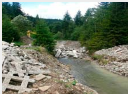
Ujęcia wody przed modernizacją.
