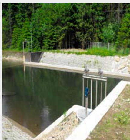
Zmodernizowane ujęcie wody.
