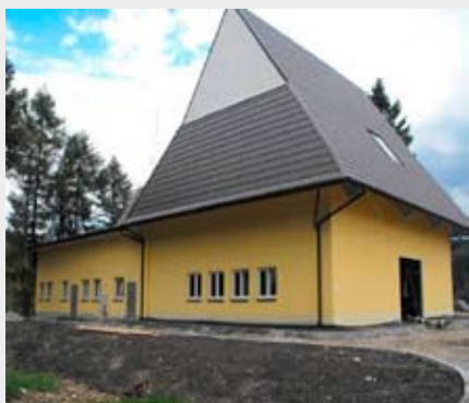
Stacja uzdatniania wody w trakcie modernizacji Zmodernizowany budynek SUW
