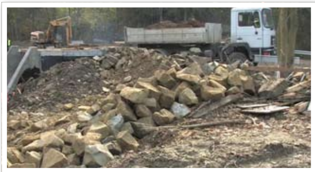
likwidacja osuwiska wzdłuż ulicy Sopotnickiej za kwotę 682 380,60 zł (dofinansowanie 545 816,00 zł)
